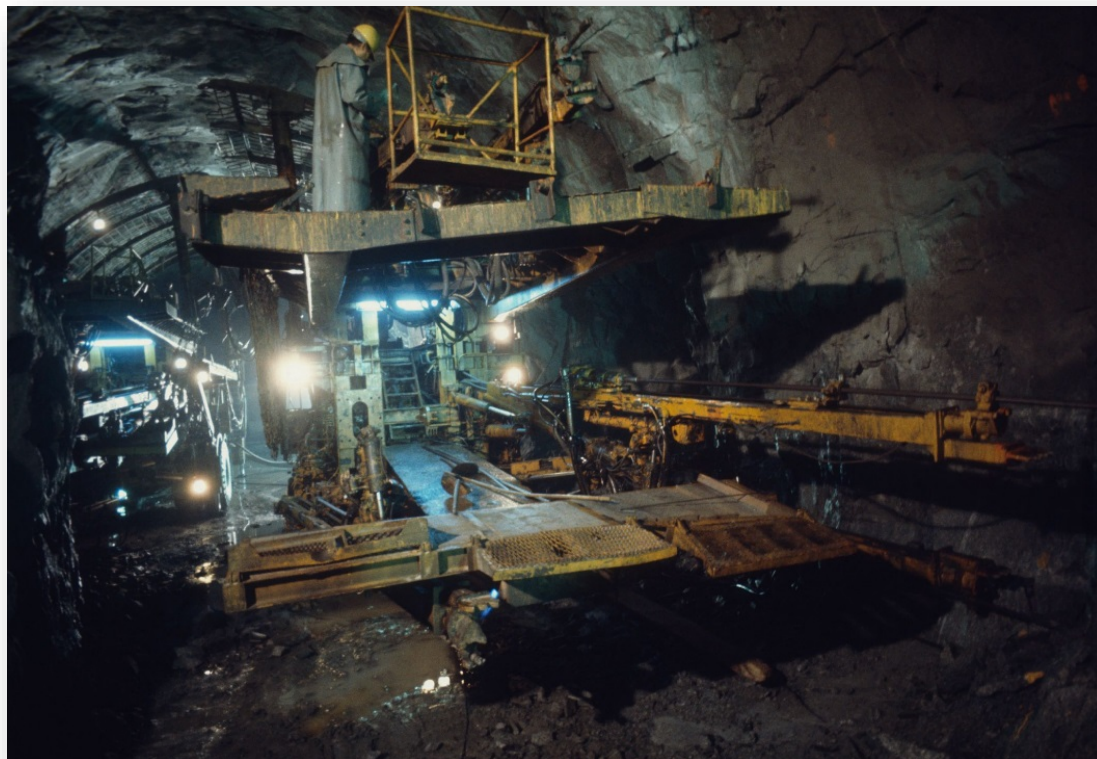
Bohrgerät auf Hebebühnen
