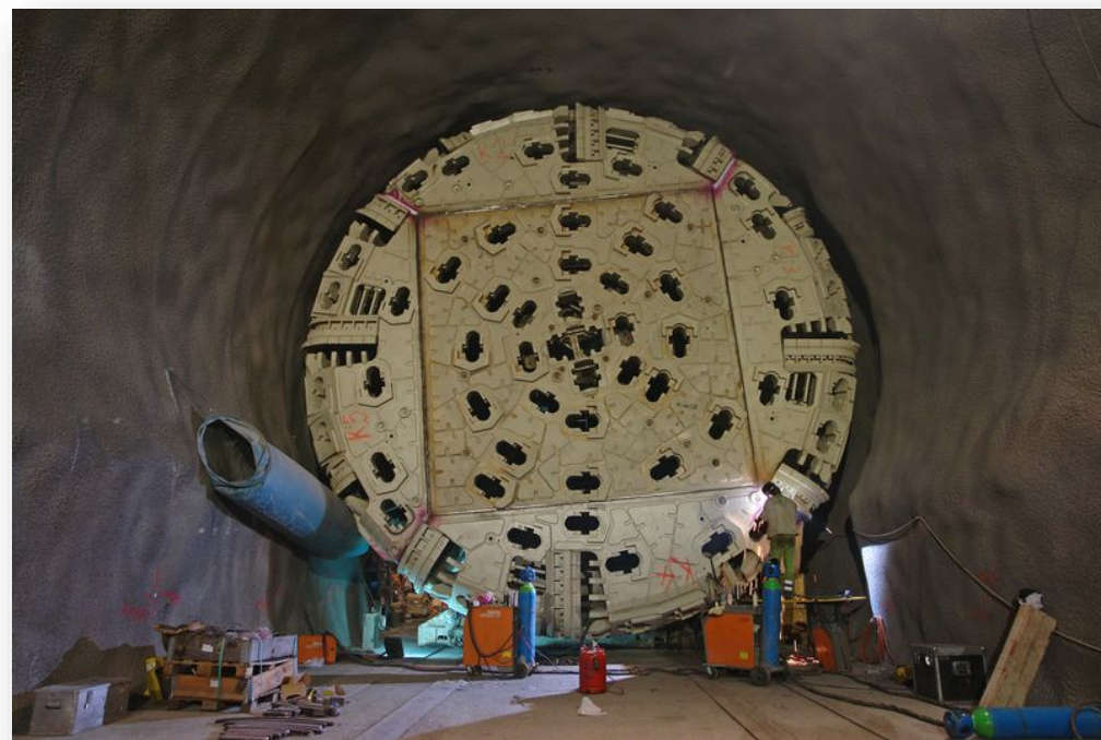
TBM Haupttröhren: 80% Ganzes Bauwerk: 64%
