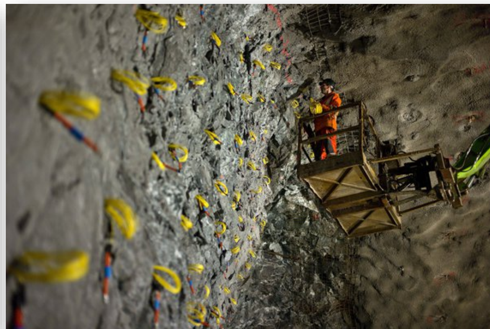
Sprengvortrieb Haupttröhren: 20% Ganzes Bauwerk: 36%
